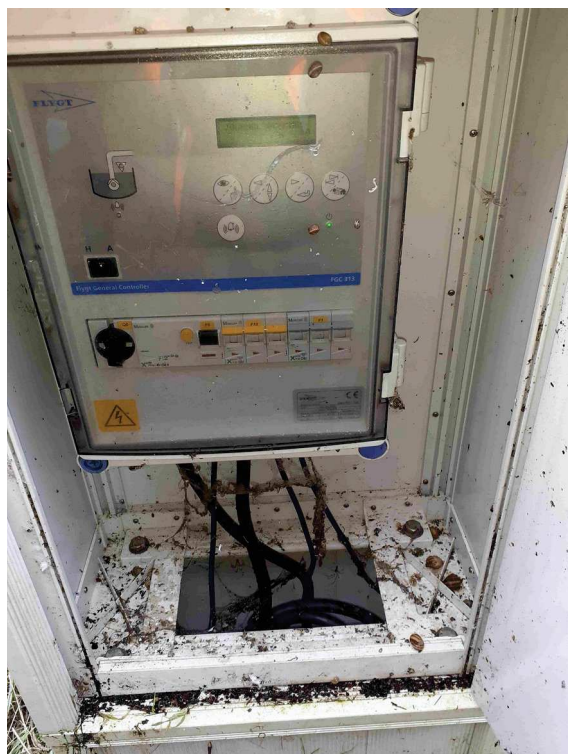
panneau de contrôle pompe de relevage
